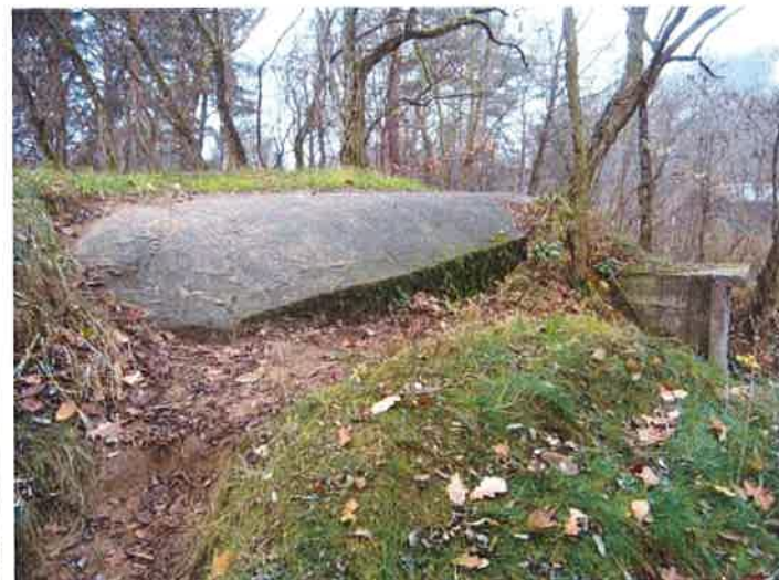
Fot. 38. Schron bojowy (3d) - widok ze wschodu na krawędź stropu i lewej ściany, na pierwszym planie fragment ściętego naroża z zasypaną całkowicie ścianą czołową, w głębi z prawej prefabrykowany przedsiönek.
