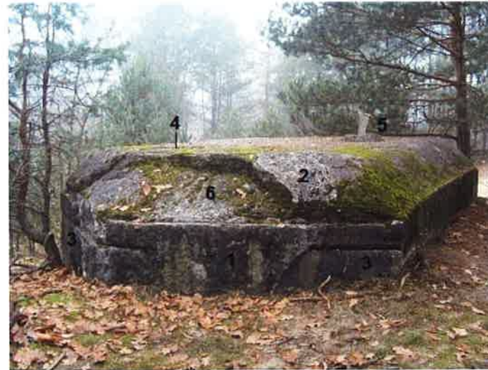
Fot. 25. Schron (3a) - widok z południowego wschodu na ścianę czołową i lewą. 1,2 - tynk maskujący na ścianie czołowej i skosie stropu z granicą tynkowania, 3 - rowki po drewnianych listwach, 4 - otwór peryskopu/rakietnicy, 5 - otwór dymowy, 6 - miejsce zniszczenia warstwy wierzchniej. Szczelina obserwacyjna zasypiana.
