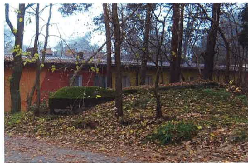
Fot. 33. Stanowisko obserwacyjne (3c) - widok ze wschodu na ścianę czołową i lewą. Widoczny grubszy strop przy ścianie czołowej, jego obniżenie i następnie łagodne wznoszenie do tylnej krawędzi obiektu. Kształt nasypu wtórny, przykrywa pozostałości rozebranych części budowli.
