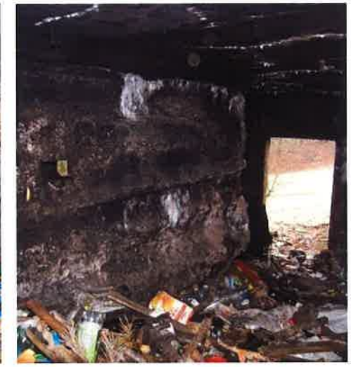
Fot. 30. Wnętrze schronu (3a) - po lewej prawa ściana izby obserwatora z odciętymi belkami i otworem instalacyjnym, w głębi przedsiionek z otworem wejściowym.
