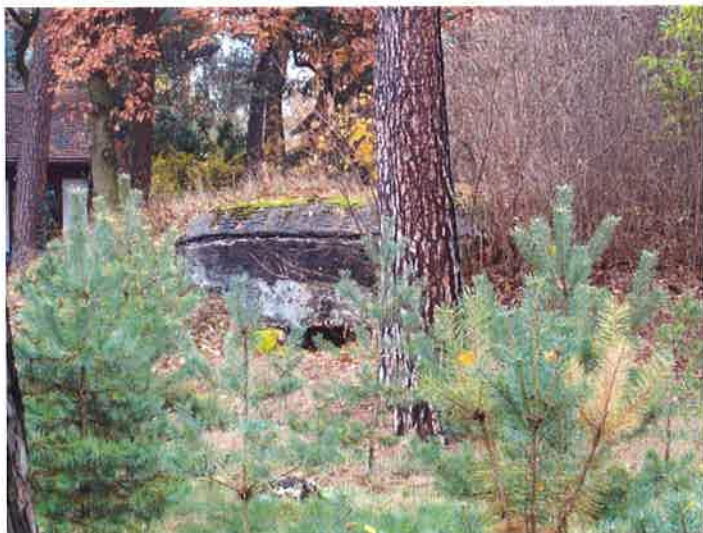
Fot. 42. Schron bojowy (4c) - widok z południowego wschodu na nasyp maskujący i ścianę czołową. Widoczne obniżenie krawędzi przy narożach, zachowany częściowo tynk maskujący, rowek po listwach mocujących tynk i częściowo zasypana strzelnica ckm.
