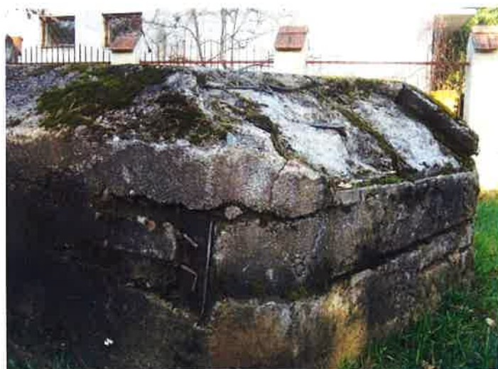
Fot. 17. Schron (2b) - naroże ściany prawej i czołowej. Widoczne fragmenty zewnętrznej siatki zbrojenia i stalowych kształtowników wzmacniających ścianę i strop, resztki tynku maskującego i poziome trapezowe rowki w ścianie czołowej oraz pozostałości pionowych rowków w zerodowanym skosie nad ścianą czołową.
