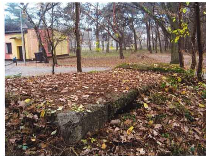
Fot. 35 i 36. Stanowisko (3c) – widok na lewą i prawą ścianę. Na obu zdjęciach na pierwszym planie naroże ze ścianą tylną i górny fragment bocznej ściany ryzalitu, zakończony odciskiem zagłębionej częściowo w ścianie pionowej belki, oraz przekrój przez strop, powstały w wyniku skucia jego dalszej części po obu stronach obiektu, z widocznymi fragmentami prętów zbrojenia. Dalej zaczyna się skos na połączeniu ściany i stropu, i następnie pogrubienie stropu nad stanowiskiem obserwacyjnym.
