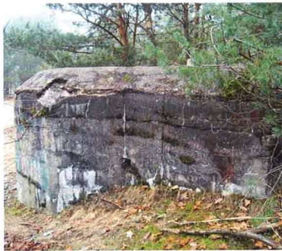
Fot. 28. Schron (3a) - widok od południa na prawą ścianę z aneksem mieszczącym zakończenie przedsiionka, na załamaniu wylot otworu instalacyjnego - przypuszczalnie na kabel telefoniczny.
