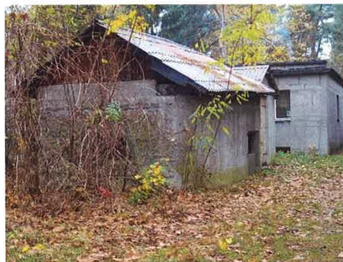
Fot. 18. Schron bojowy (2c), zaadaptowany na cele gospodarcze i rozbudowany - widok z południowego wschodu na ścianę czołową z otworem strzelniczym ckm (po lewej) i prawą z częściowo zamurowanym wejściem do przelotni, górne krawędzie ścian nadmurowane współcześnie.
