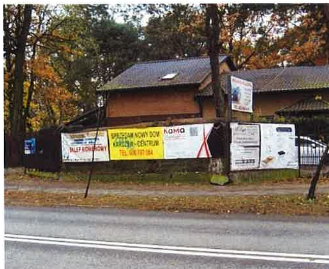
Fot. 43. Schron bojowy (4d) zasłonięty od ulicy ogrodzeniem i banerami, widoczny nad ogrodzeniem strop obniża się w lewo - ku ścianie czołowej. Widok z północnego wschodu.
