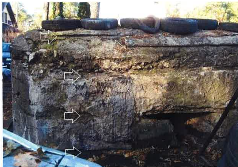
Fot. 45. Schron (4d) - widok ściany czołowej ze strzelnicą ckm z resztkami rozkutego zamurowania i odsłoniętym lewym półczkiem. Wokół strzelnicy zachował się tynk maskujący, strzałki wskazują rowki o trapezowym przekroju po drewnianych listwach do jego mocowania.
