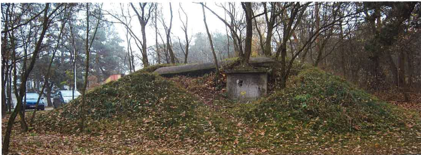
Fot. 37. Schron bojowy (3d) - widok ogólny z kierunku północnego, na lewą ścianę. Na pierwszym planie teren współcześnie splantowany poniżej poziomu wejścia do schronu. Nasyp przekształcony podczas adaptacji przez Obronę Cywilną zasłonił cały schron poza dostawionym do północnego wejścia przelotni prefabrykowanym przedsiönkiem, osunięcie ziemi odsłoniło krawędź lewej ściany i stropu oraz zakryło w 1/3 zamurowane wejście. Widoczne wyjątkowo duże nachylenie stropu do przodu.
