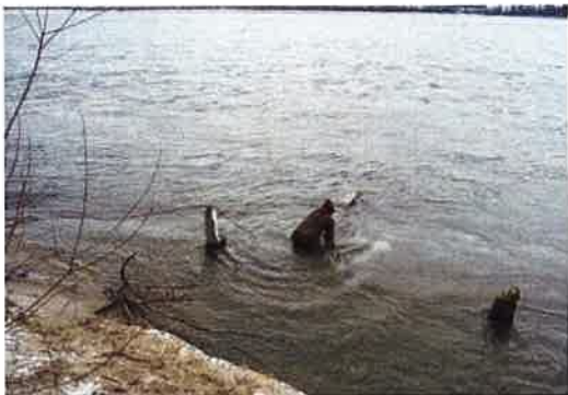
Fot. 48. Pozostałości mostu w Świdrach Mł. (5a) - oględziny odsłoniętych przy prawym brzegu słupów i stalowej belki. Fot. S. Fuglewicz, 2012 r.
