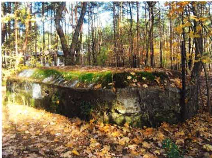
Fot. 14. Schron obserwacyjny (2a) - widok z południowego zachodu na ścianę prawą i czołową z zachowanym tynkiem maskującym i poziomym rowkiem po listwie do jego mocowania, w skosie nad ścianą czołową rowki pionowe. Szczelina obserwacyjna pod obecnym poziomem terenu.
