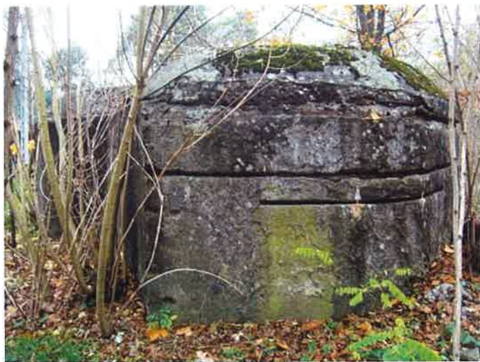
Fot. 40. Schron (3f) - widok z południowego wschodu na ścianę czołową, z lewej w skrócie ściana prawa i wysunięta część przelotni. Widoczny częściowo zachowany tynk maskujący - usunięcie nasypu i obniżenie terenu odsłoniło granicę jego pierwotnego zasięgu. Nad szczeliną obserwacyjną dwa rowki po drewnianych listwach, przy górnym ubytki odsłaniające pręt zbrojenia.
