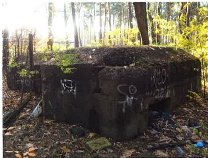
Fot. 15. Schron (2a) - widok z północnego wschodu na ścianę tylną z zasypnym w większości wejściem i lewy bok schronu z dochodzącym do lica ściany przedsionka dwuteownikiem, wzmacniającym jego strop. Schron położony na terenie dwóch działek - widać ogrodzenie, za którym znajduje się jego narożnik.
