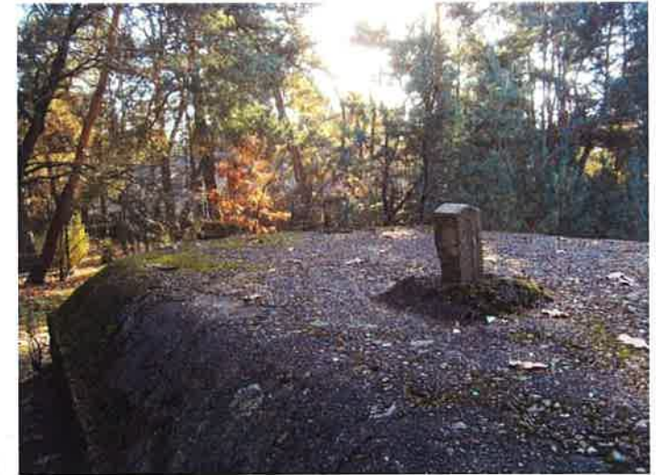
Fot. 26. Schron (3a) - wykończenie krawędzi stropu i otworu dymowego (z wrzuconym słupkiem z ogrodzenia), w głębi przy krawędzi skosu nad ścianą czołową otwór dla peryskopu.
