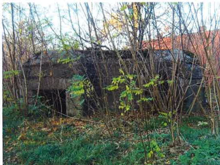
Fot. 39. Schron obserwacyjny (3f) - widok z południa na prawą ścianę z wejściem do przelotni po lewej, z prawej widoczny skośny odcinek ściany czołowej z rowkami po listwach i szczeliną obserwacyjną.
