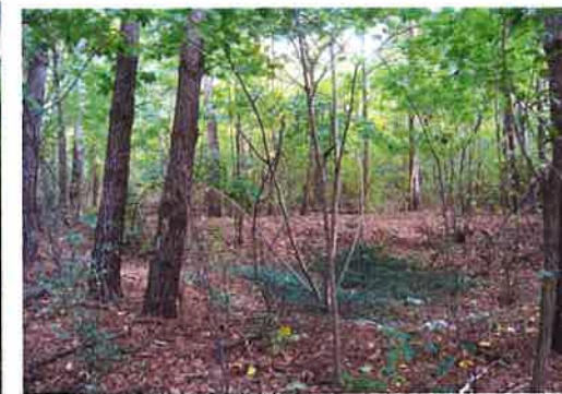
Fot. 55. Jeden z wykopów pod schrony (6a) przy ul. Wyszyńskiego, widok z południowego zachodu.
