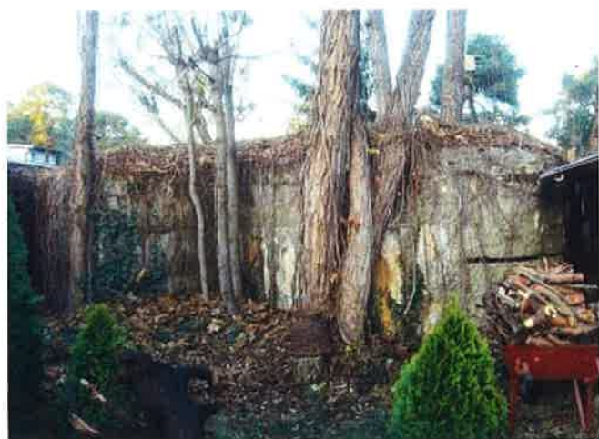
Fot. 23. Schron obserwacyjny (2f) - widok z południowego zachodu na ścianę prawą z aneksem przedsionka i wieloboczną ścianę czołową ze szczeliną obserwacyjną i zachowanym tynkiem maskującym.
