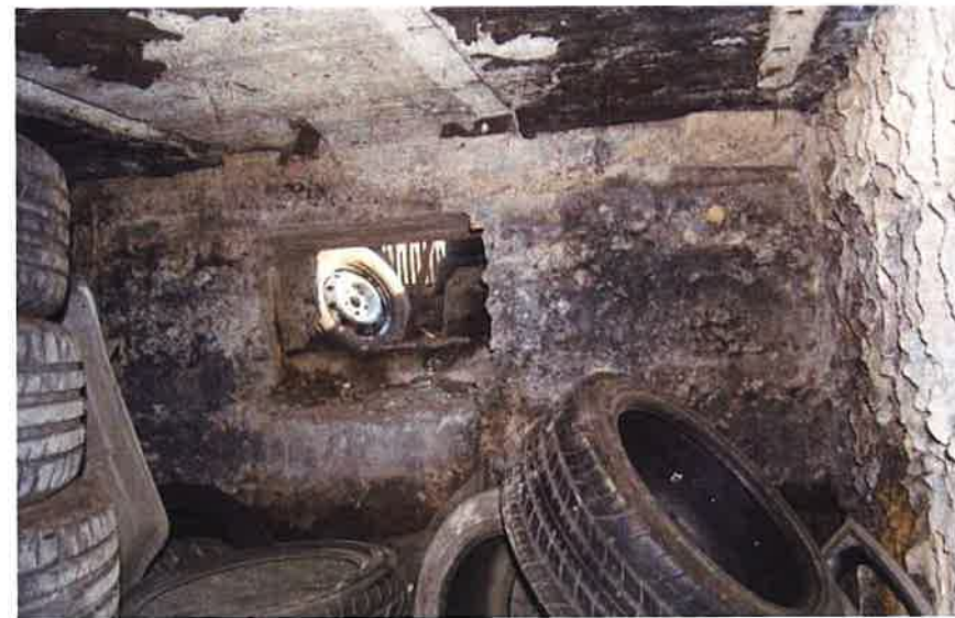
Fot. 47. Schron (4d) - wnętrze izby bojowej. W ścianie czołowej strzelnica ckm we wnęce z zabetonowanymi w półkach drewnianymi klockami i zagłębieniem poniżej na dostawiany do ściany drewniany podest. W ścianie prawej ślady zerwanych arkuszy blachy falistej, w stropie wzdłużne bruzdy i resztki wtórnie naklejonej papy.
