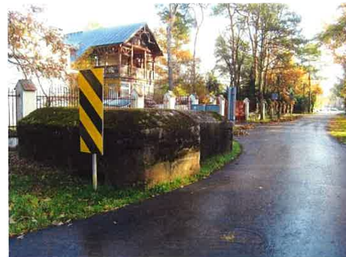
Fot. 16. Schron obserwacyjny (2b) - widok z północnego zachodu na tylną ścianę z zasypnym wejściem i prawy bok z aneksem przedsionka.
