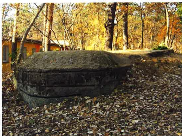
Fot. 34. Stanowisko (3c) – stan w 2011 r. po oczyszczeniu i częściowym odkopaniu, widok na ścianę czołową i lewą. Widoczny tynk maskujący na skosie i górnej części ściany czołowej, dwa rowki po drewnianych listwach i pod nimi szczelina obserwacyjna o pochylonej płaszczyźnie. Z prawej zakończenie skosu i dalej krawędź po skuciu części przedłużonego w bok stropu.
