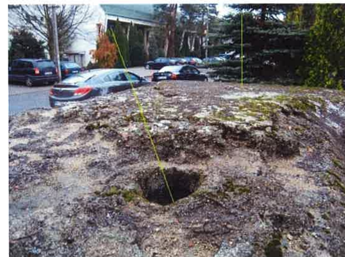
Fot. 22. Schron (2d) - widok z południa na strop - widoczne otwory dla peryskopu/rakietnicy i dymowy (z zaznaczonymi osiami) oraz uszkodzenia ograniczone do przedniej części stropu.
