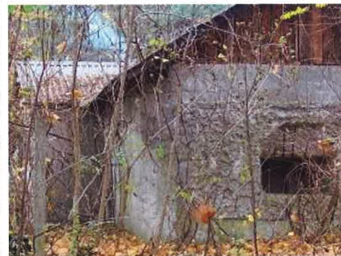
Fot. 19. Schron (2c) - ściana prawa i czołowa, w głębi współczesna przybudówka do tylnej ściany. Widoczna strzelnica ckm, zbrojenie w jej nadprożu i zasięg tynku maskującego na obu ścianach.
