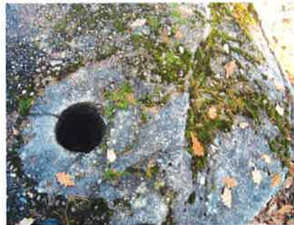
Fot. 27. Schron (3a) - otwór dla peryskopu i/lub rakietnicy, nachylony w kierunku ściany czołowej (krawędź widoczna po prawej).
